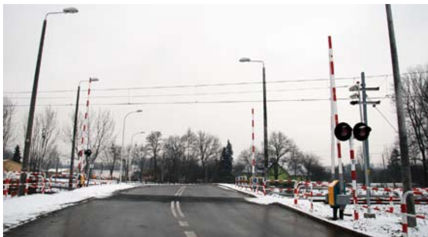
Na oddanym do użytku odcinku drogi powstał monitorowany przejazd kolejowy. (fot.: BZ)
